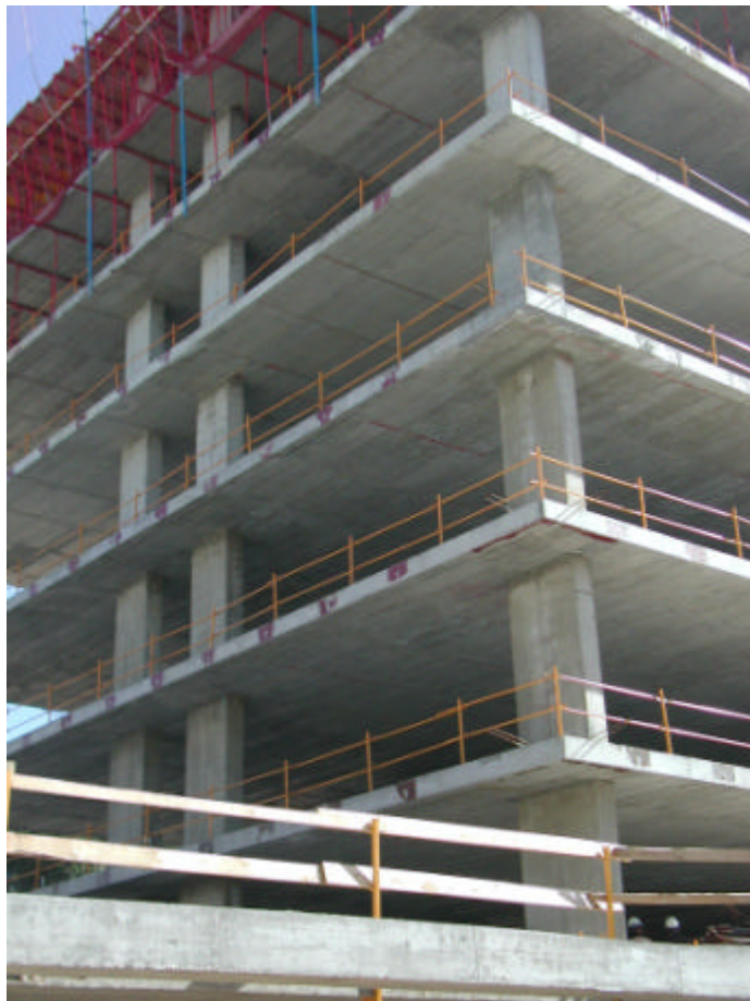
Fotografía 1.1: Vista general de la construcción de un edificio con forjados de placas macizas de hormigón.
