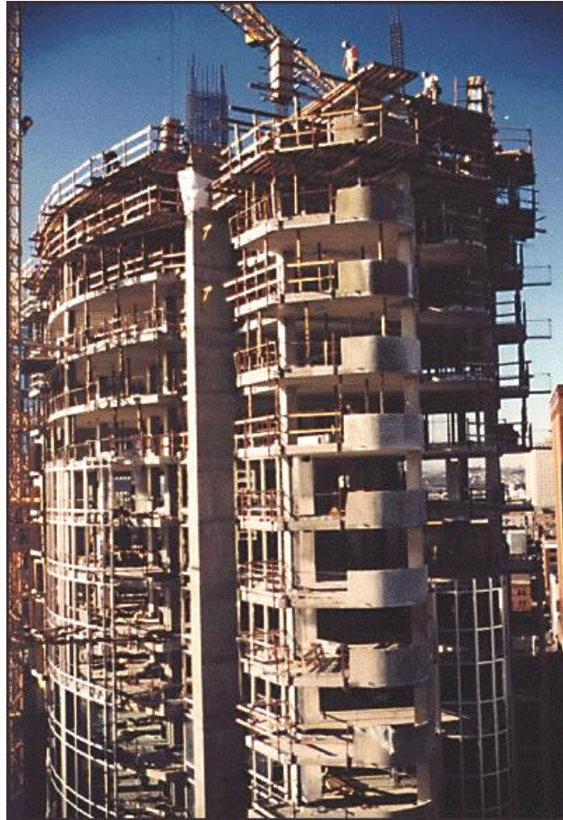
Fotografía 1.2: “One Pacific Towers”, edificio de 27 plantas construido en EEUU en 1995, en zona sísmica 4, utilizando placas macizas de hormigón de alta resistencia.
