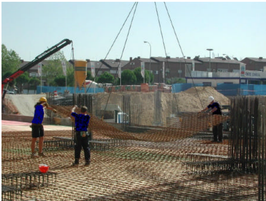
Fotografía 4.2: El empleo de mallas electrosoldadas facilita el armado de las placas.
