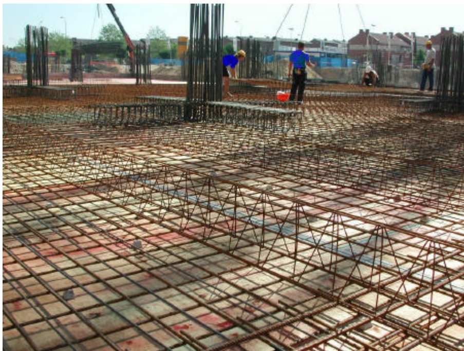
Fotografía 4.1: Una etapa en el proceso de armado de una placa maciza.
