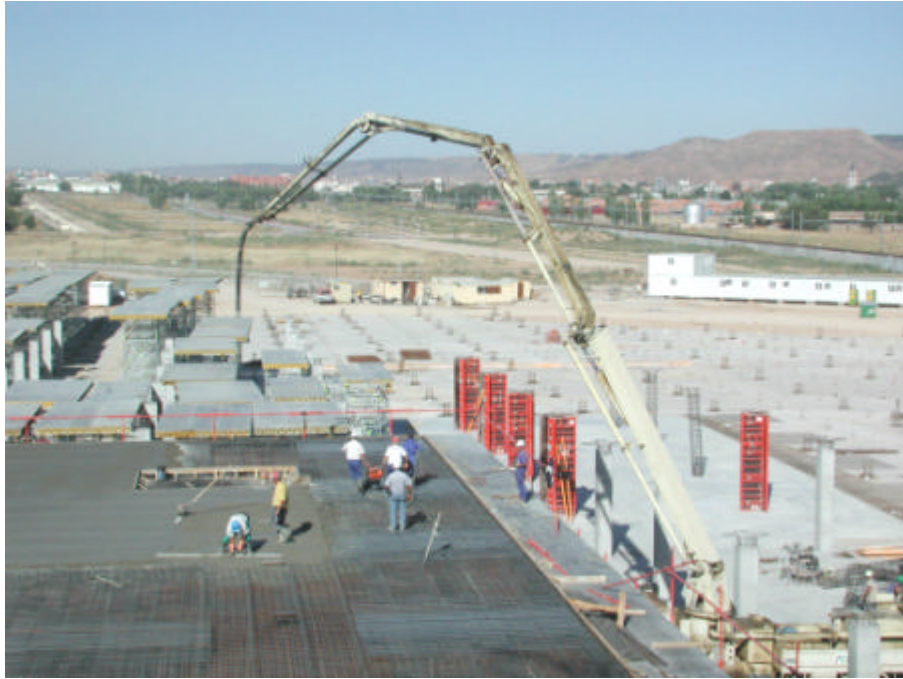
Fotografía 2.2: Es fundamental garantizar la calidad de ejecución de la obra, especialmente en las etapas de vertido, vibrado y curado del hormigón.
