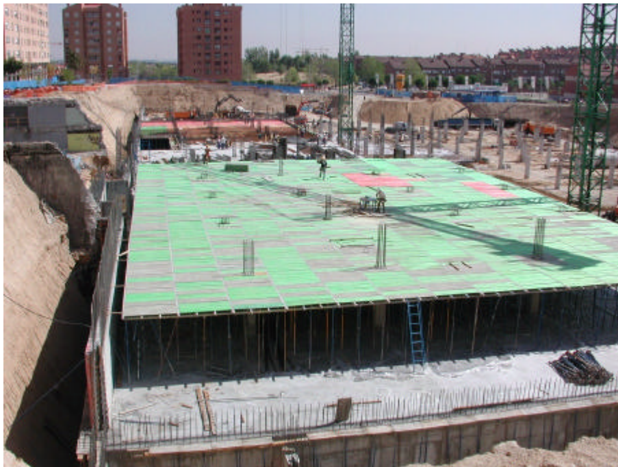
Fotografía 5.1: Vista general de encofrados de placas macizas.
